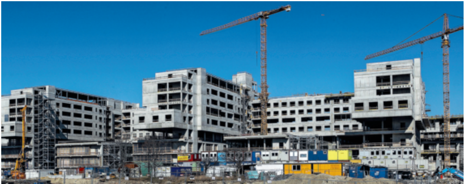
Krankenhaus Nord: Der Rohbau ist fertig, jetzt wird es richtig kompliziert
