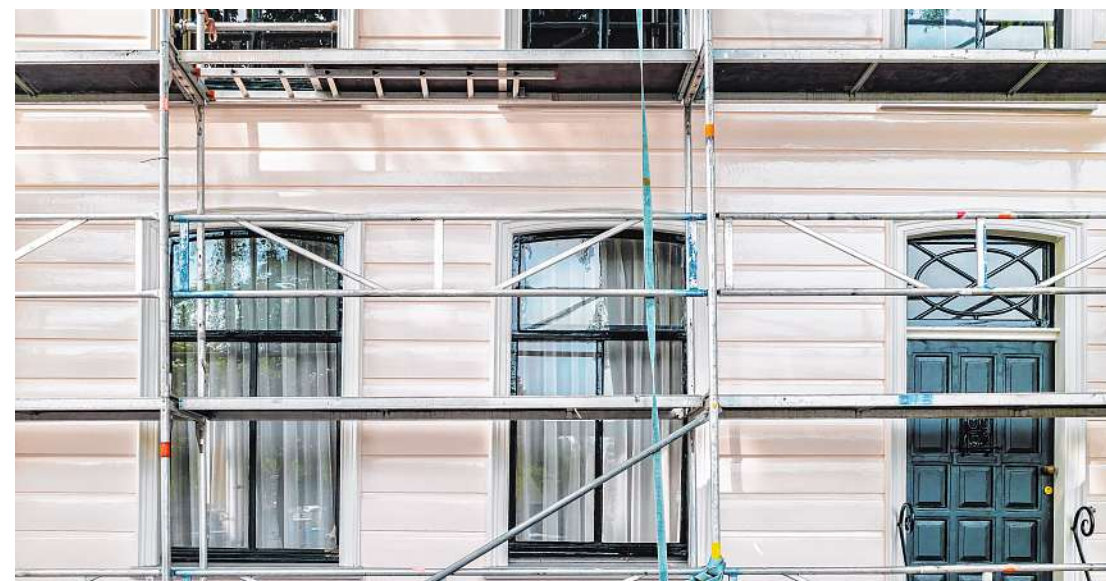
Auch die Sanierung der Fassade wird von allen Wohnungseigentümern gemeinsam finanziert
